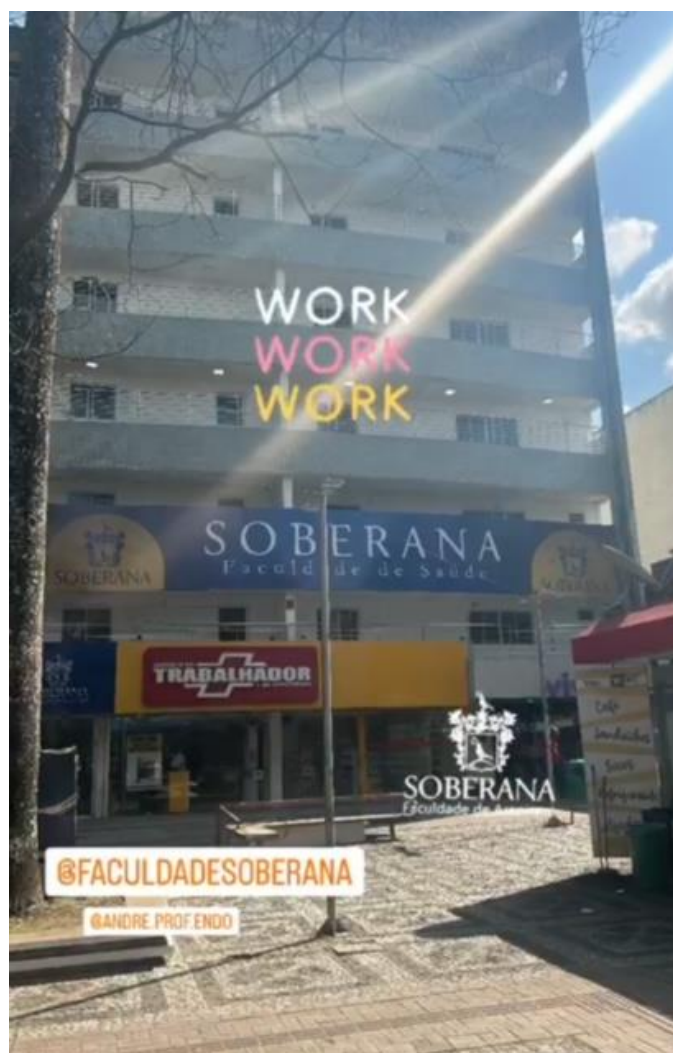
Fonte: Faculdade Soberana de Arapiraca, 2023 – Nova fachada
